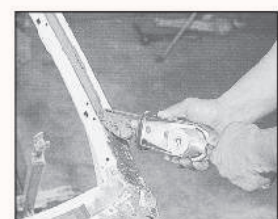
平面の塗膜ハガシ(MB20S)
